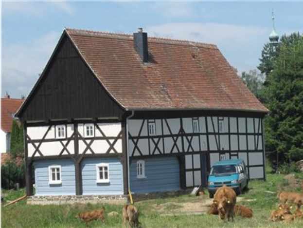
Das schön sanierte Umgebindehaus unweit der Dorfstraße in Oberseifersdorf.
