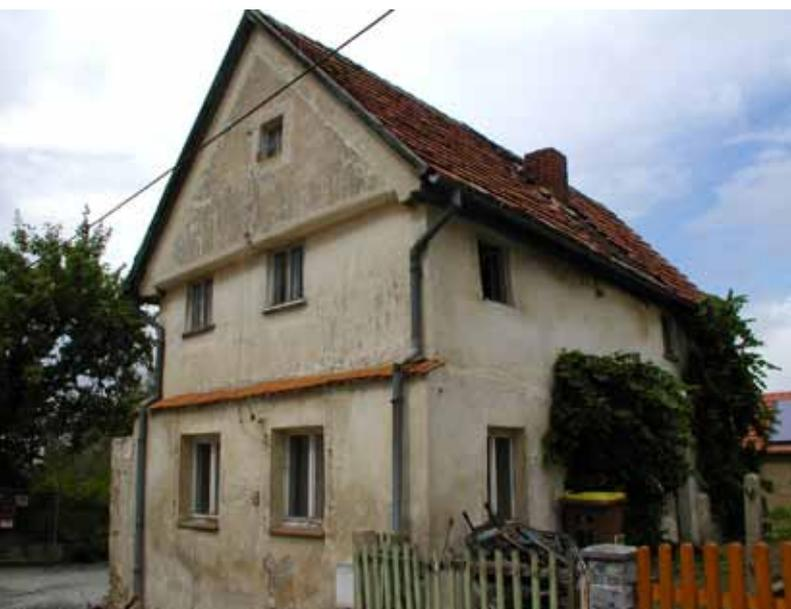
*2009 sah man noch nichts von der alten Schönheit und der seltenen Holz Konstruktion, die unter dem dicken Kalkputz verborgen war. Der Abriss stand kurz bevor.*
