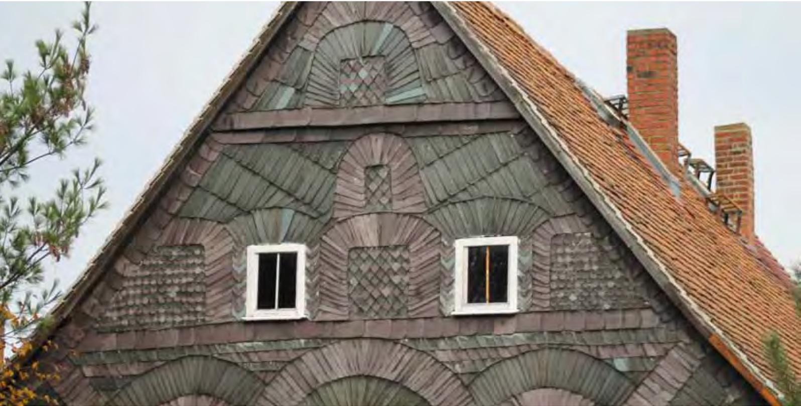
*Auch ein besonders aufwendig gestalteter Schiefergiebel in Großschönau wurde in den letzten Jahren durch Instandsetzungs- und Sicherungsarbeiten in seiner Originalität für die Nachwelt gesichert. Im Rahmen der Kleinprojektförderung flossen auch Mittel der Stiftung Umgebendehaus mit ein.*
