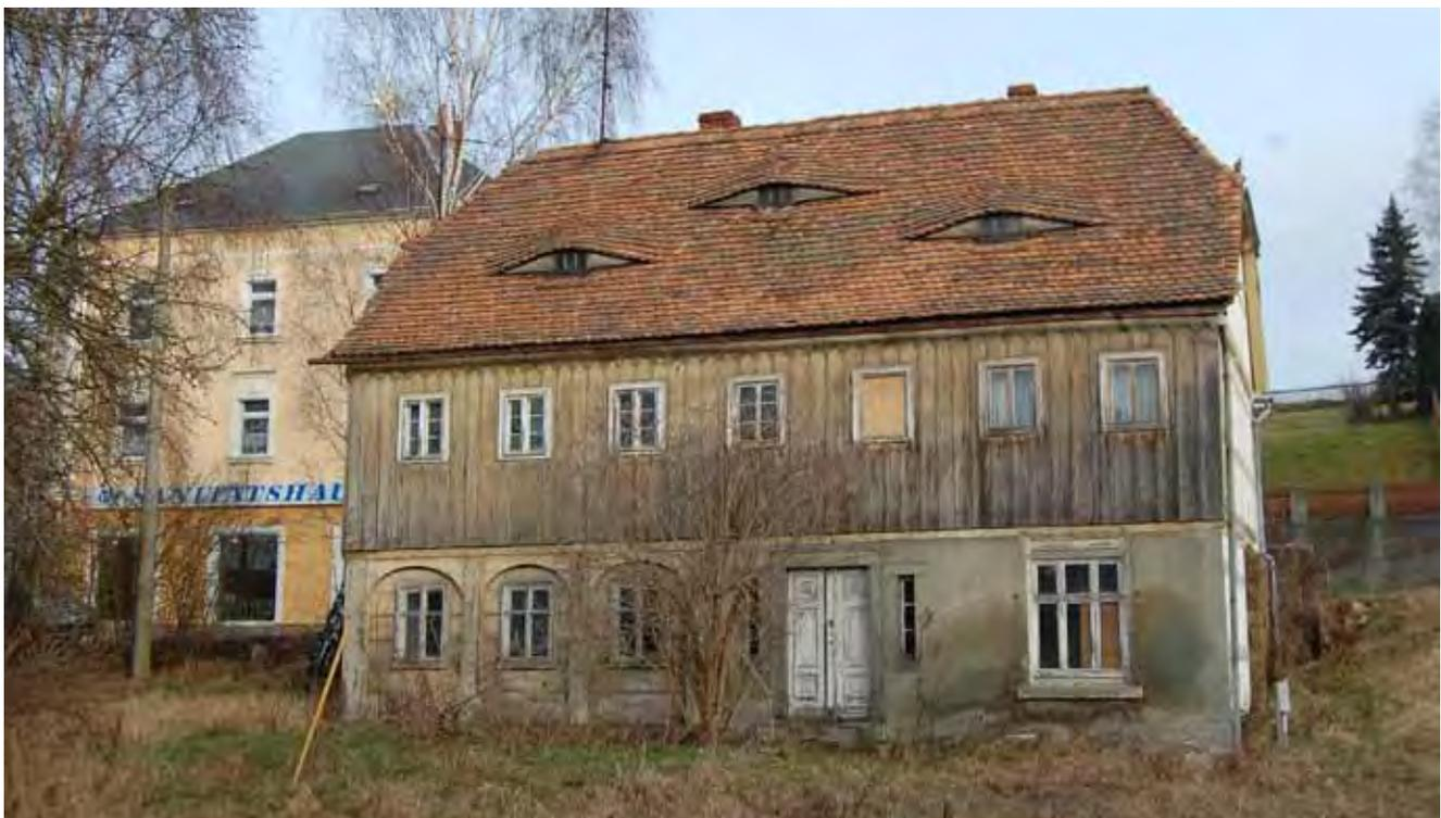
*Dieses Umgebindehaus in Ebersbach-Neugersdorf befindet sich unmittelbar an der B 96. Im Zusammenhang mit einer geplanten Umsetzung werden sämtliche intakten Holz- und Natursteinbauteile für einen späteren Wiederaufbau geborgen (z.B. Dachziegel, Tür- und Fenstergewände, Umgebinde, Blockstube, Teile der Fachwerkkonstruktion und der Holzbalkendecken).*
