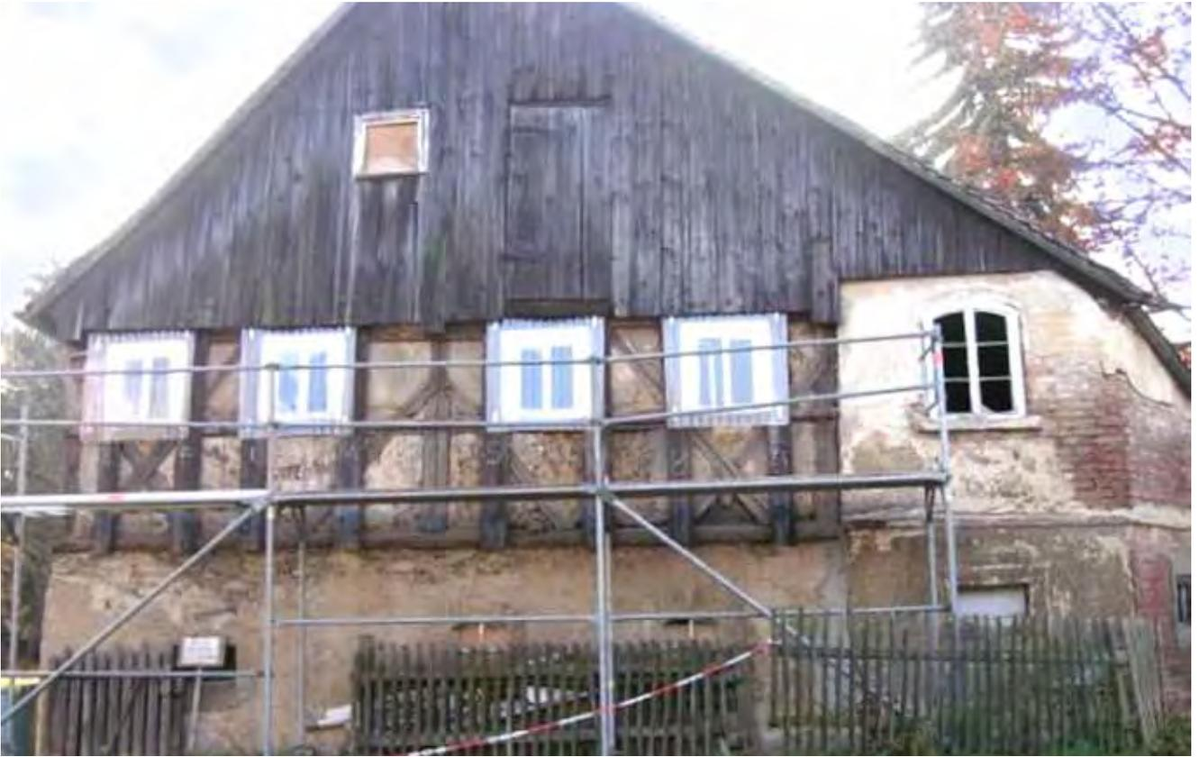
*Das dendrochronologisch auf 1614 datierte Haus vor und nach der Instandsetzung (oben der Zustand mit jüngerem Anbau; unten nach Abbruch des Anbaus, Fachwerkinstandsetzung und Rekonstruktion des Schopfwalms)*
