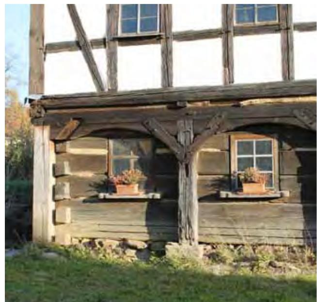
*Lehmbauarbeiten und die Erneuerung von Holzbauteilen konnten im Rahmen der Kleinprojektförderung erfolgen.*
