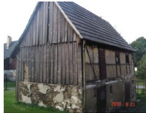
Abb. E-9: massiver Schuppen mit Fachwerkobergeschoss, Großhänchen (Foto: Marticke)
