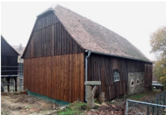
Abb. E-8: Holzscheune mit eingebautem massiven Pferdestall, Ebersbach
