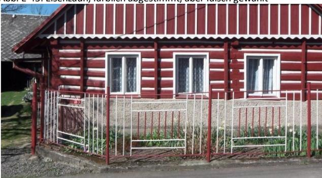
Abb. E-44: Possensäulen und profilierte Brettlaten! (Foto: J. Cieslak)
