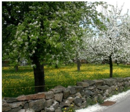
Abb. E-29: Granittrockenmauer
