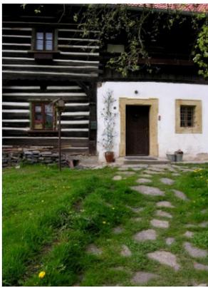
**BAUKUNDE:** Die wohl wichtigste befestigte Fläche des Hofes war und ist die große Natursteinplatte vor der Haustür. Je nach Geländesituation ist sie bodengleich verlegt, bildet eine Stufe oder zusammen mit anderen gehauenen Steinen eine kleine Treppenanlage. Wurde Sandstein verwendet, erzählt der ausgetretene Bereich von der steten Nutzung.
