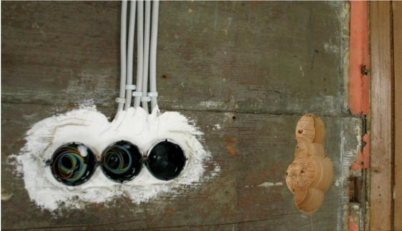
Abb. D-39: Installationsarbeiten sorgfältig planen und substanzschonend arbeiten
