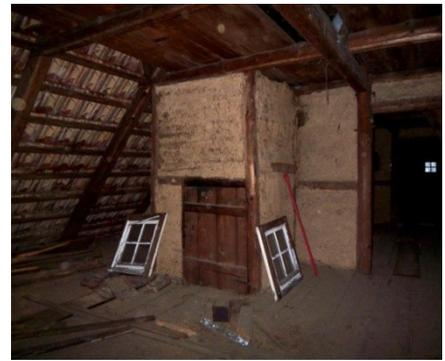
Abb. D-4 und Abb. D-5 verputzter Rauchfang im Ober- und Dachgeschoss, Ličenice, 2008
