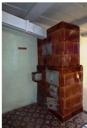
Später erfolgte die Trennung von Heizen und Kochen. Beim Heizofen in der Stube verblieben durch den Einbau eines ausgeklügelten Zugsystems in den ursprünglichen Hohlofen die heißen Rauchgase länger im Ofen. Die abgestrahlte Wärme hielt so länger an. Zum Kochen errichtete man gesonderte Herde in verschiedenen Ausführungen, die allerdings auch die mittlerweile separate Küche beheizten.
