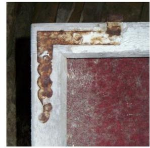
Abb. C-136 zerstörte Wetterschenkel, aufgeplatzte Quersprosse, stark verrosteter Beschlag, bereits mit Fehlstellen
