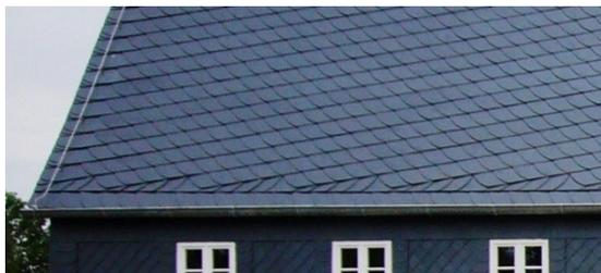
Anstelle einer verschlissenen altdeutschen Deckung wird heute meist die Deckung mit (preiswerteren) Bogenschnittschablonen angeboten und ausgeführt, deren Ränder ebenso eingebunden sind. Der Verlust an Lebendigkeit ist allerdings deutlich erkennbar.
