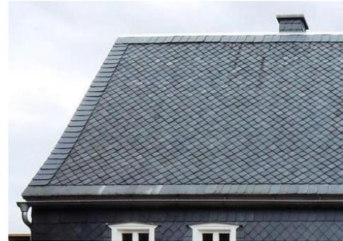
Abb. C-21 Deckung mit fünfeckiger Spitzwinkelschablone (Zeichnung: Vojtisek)
