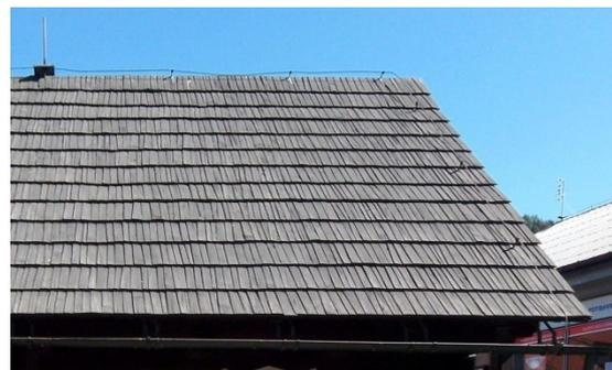
Abb. C-5 Abbildungen: Zeichnung aus Ahnert, R., Krause, K. (1985). *Typische Baukonstruktionen von 1860 bis 1960, Band I*. Berlin: VEB Verlag für Bauwesen, S 193/ Schindeldach (Schlesische Schindel) in Nordböhmen
