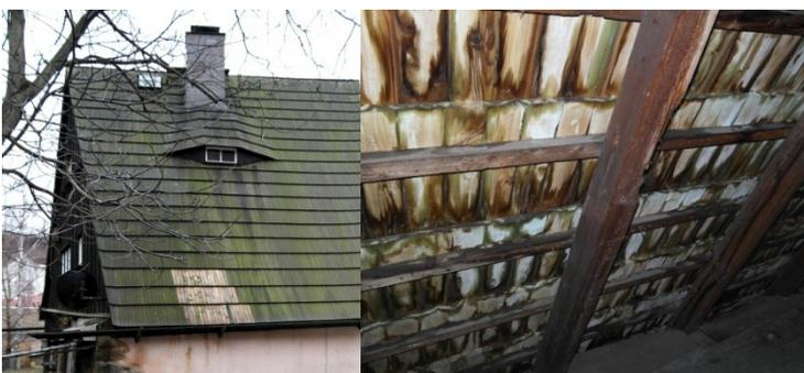
Abb. C-6 schwer geschädigtes Holzschindeldach
