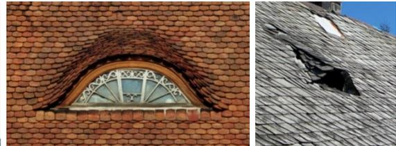
Abb. C-41 Als „**Ochsenaugen**“ bezeichnete Sonderform der Fledermausgauben (Den Namen geben die (halb)runden Fenster), in Ziegelddeckung (Großschönau) / in Schieferdeckung (Železný Brod)
