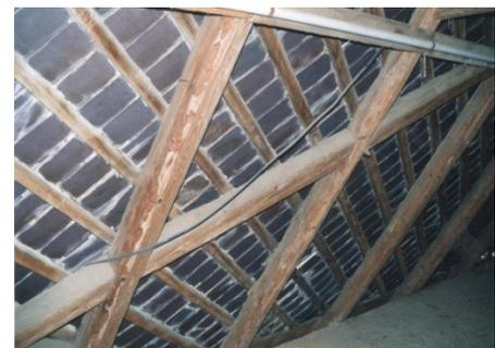
Abb. C-20 Deutsche Einfachdeckung mit Gebindeanstieg und aufgelegtem Rand
