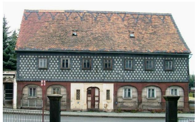
Abb. C-12 Die Kleinformatigkeit der Biberschwänze ließ das Einarbeiten solcher schmückenden Elemente zu.
