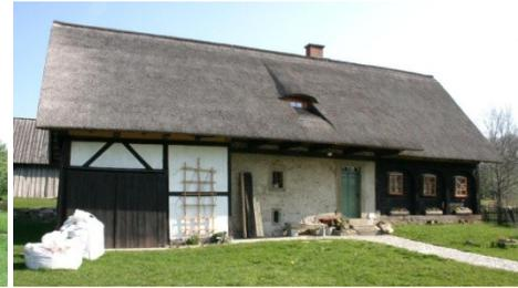
Abb. C-4 Veränderungen eines ehemaligen Strohdaches einschließlich Gaube in Schönbach: 2005: Bandrutendach (nach Deutschmann) 2009: neues Rohrdach (Foto: Dr. Rosner) 2012: Dachfläche natürlich gedunkelt
