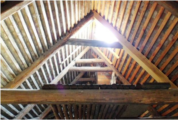
Der über Jahrhunderte als Speicher genutzte Dachraum eines alten Hauses sollte aus folgenden Gründen **nicht ausgebaut** werden: Der Dachraum stellt eine thermische Pufferzone zwischen beheiztem Wohngeschoss und Außenluft dar. Die Dachdeckung einschließlich Lattung oder Schalung wird gut belüftet, alle Konstruktionsteile sind kontrollierbar und für notwendige Reparaturen leicht zugänglich. Ein historischer Dachstuhl bleibt vollständig sichtbar.
