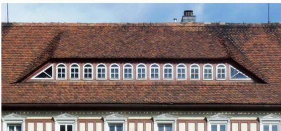
Abb. C-38 Hecht wird deutlich zum Belichtungselement (Oderwitz)
