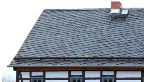
Abb. C-18 altdeutsche Deckung mit Gebindeanstieg und eingebundenen Rändern (Zeichnung aus Mittag, M. (1952). *Baukonstruktionslehre*. Gütersloh: C. Bertelsmann Verlag, bearbeitet) / altdeutsch gedecktes Dach in Krumhermsdorf (Sächs. Schweiz)
