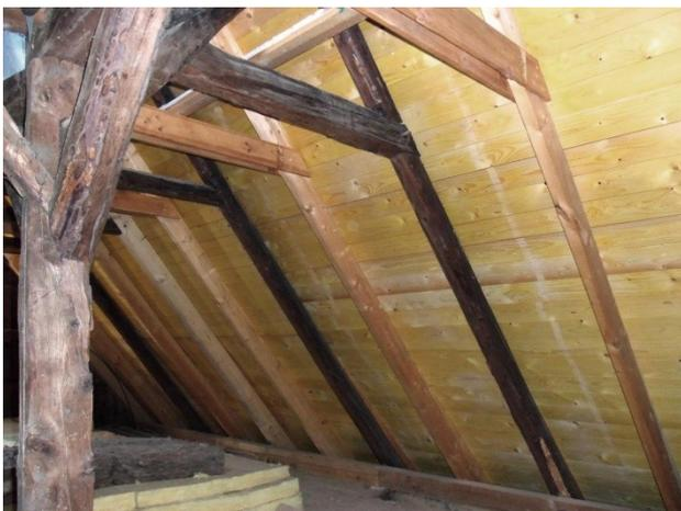
Abb. C-50 vorhandene Sparren durch zweite Sparrenlage „unterstützt“
