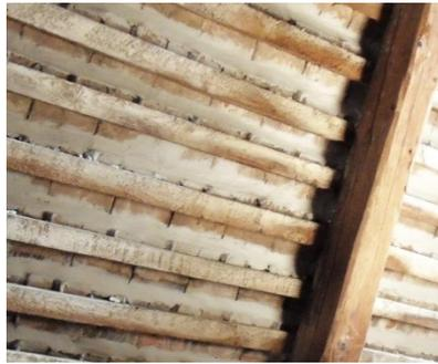
Kleine Fehlstellen in einer plattenförmigen Ziegelddeckung lassen sich relativ einfach durch das Einschleiben gleichartiger Altziegel und das anschließende unterseitige Vermörteln beheben.
