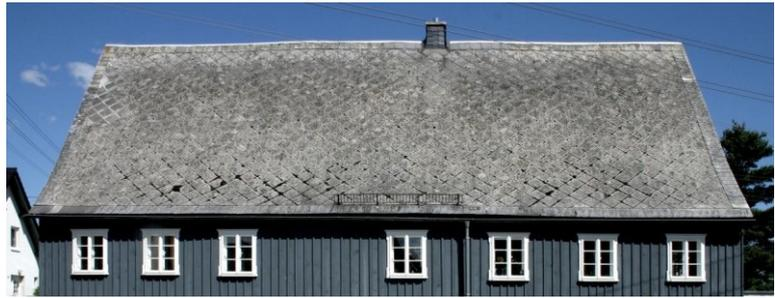
Abb. C-25 mit „Eternit“ gedeckte Häuserreihe in Hrubá Horka / patinierte, teilweise bemooste Dachfläche in Weifa
