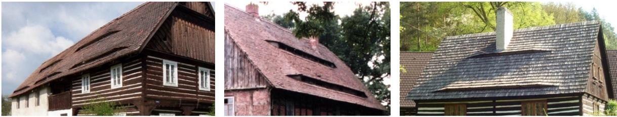
Abb. C-35 Lüftungs„bänder“ in Höhe der Dachgeschoss- bzw. Spitzbodenfußböden Lhota (Ústecký kraj), Wartha (Landkreis Bautzen) und Bukovec (Okres Česká Lípa/Foto: J. Cieslak, bearbeitet)
