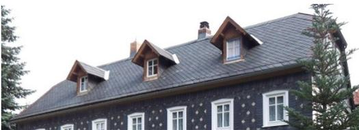
Bedrohliche „Dachparade“: Die Entstellung, die zu große Dachüberstände am Hauptdach bewirken, tritt erst recht bei Satteldachgauben ein. Diese hier wurden mit Pfetten und Flugsparren „ausgerüstet“. Die Kehlbleche drängen sich optisch auf. (Wobei man hinterfragen muss, ob hier nur der um 1900 beliebte Heimatstil instand gesetzt wurde. Dagegen spricht die Gestalt des Hauptdaches.)
