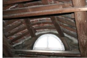
Der Gaubeneinbau war zunächst außer dem Eingriff in den Dachbelag mit keinerlei statischen Veränderungen des Dachtragwerkes verbunden, die Sparrenlage blieb ungestört erhalten. Die Einzelgaubenöffnung war im Bereich nur eines Sparrenfeldes realisierbar.
