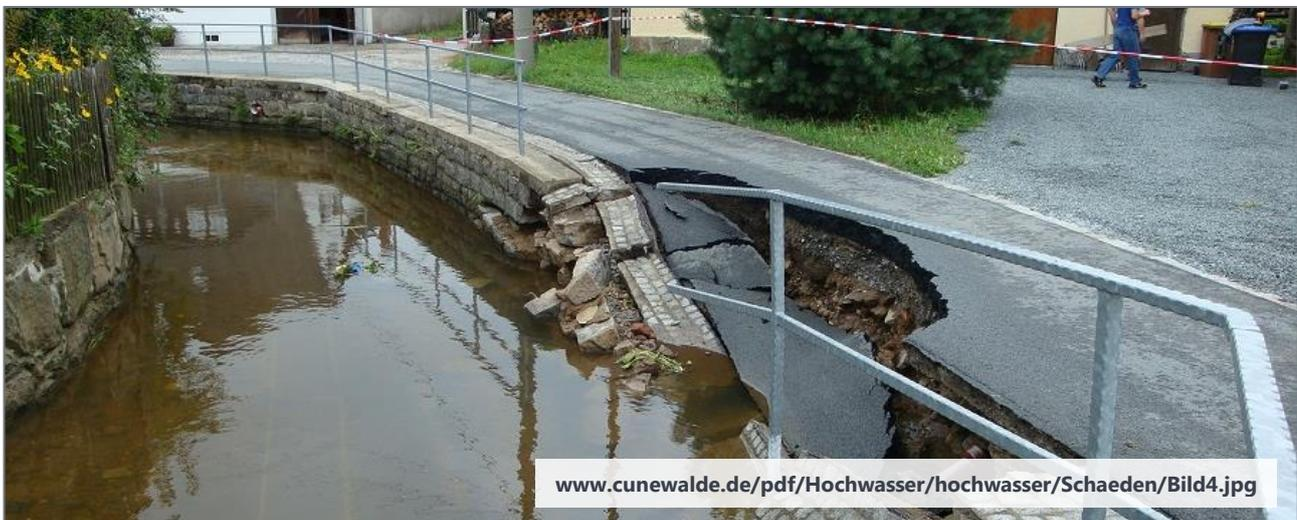
**Abb. 10: Cunewalde – zerstörte Stützmauer mit dahinter liegender Straße**
