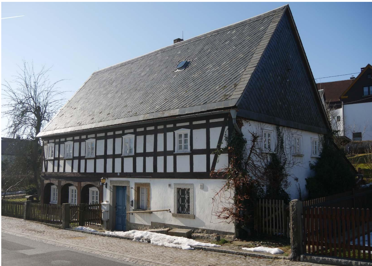
Nordost-Ansicht Umgebindehaus Schönberg Nr. 15
