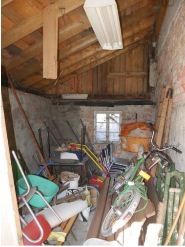
Anbau EG, Geräteraum
