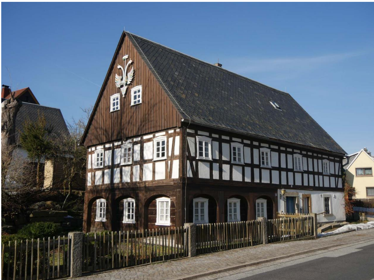
Südost-Ansicht Umgebindehaus Schönberg Nr. 15
