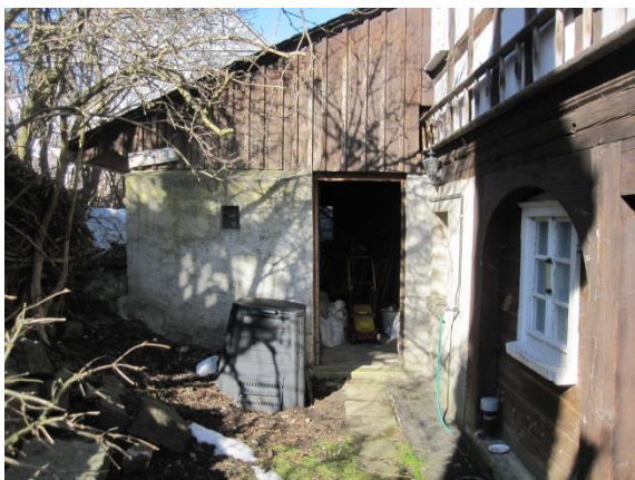
Westseite/ Rückseite, Anbau
