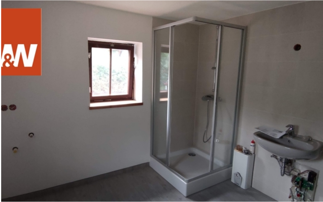
Bad OG (Restarbeiten notwendig)
