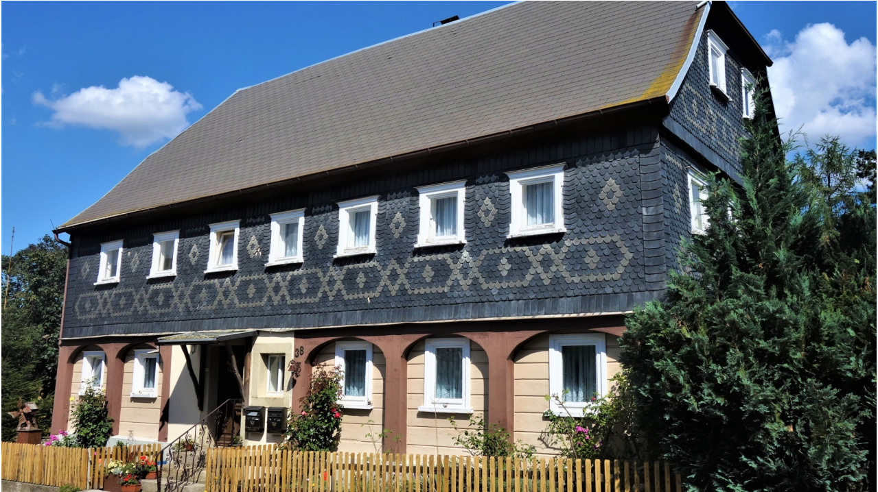
Ansicht von vorn
