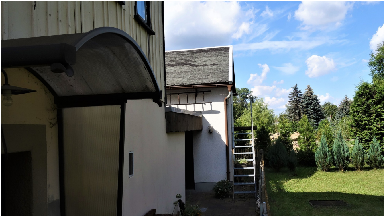
Ansicht hinterer Teil
